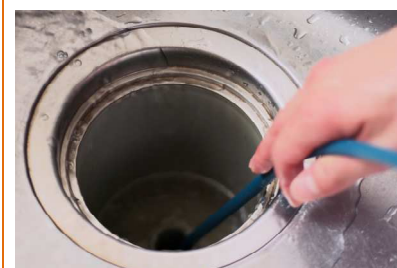
キッチンなどの排水口からホースを挿入して高圧洗浄します。
